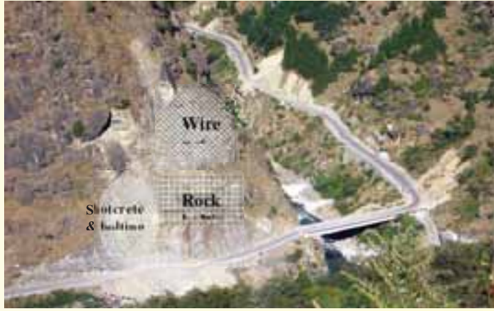
आकृति 6: चट्टान खिसकने को रोकने के लिए रॉक बोल्टिंग एवं वायर नेटिंग
