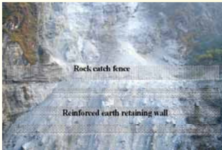
आकृति 8: चट्टान एवं मलबा स्खलन रोकने के लिए चट्टान जकड़न हेतु बाड़
